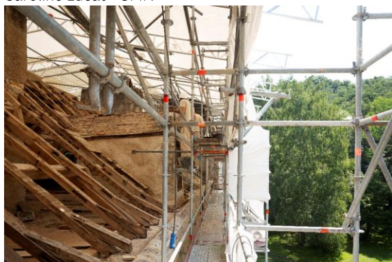
Restauration des toitures de l'aile du réfectoire © Marie-Caroline Lucat - CMN
