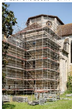
Façade est sous échafaudage et chevet de l'église abbatiale © Marie-Caroline Lucat - CMN
