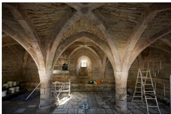
Salle capitulaire en restauration © Marie-Caroline Lucat - CMN
